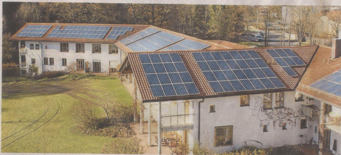
Ein kleiner Solarpark ist auf den großen Dächern des Altenheims „Steigenberger Hof“ entstanden.
