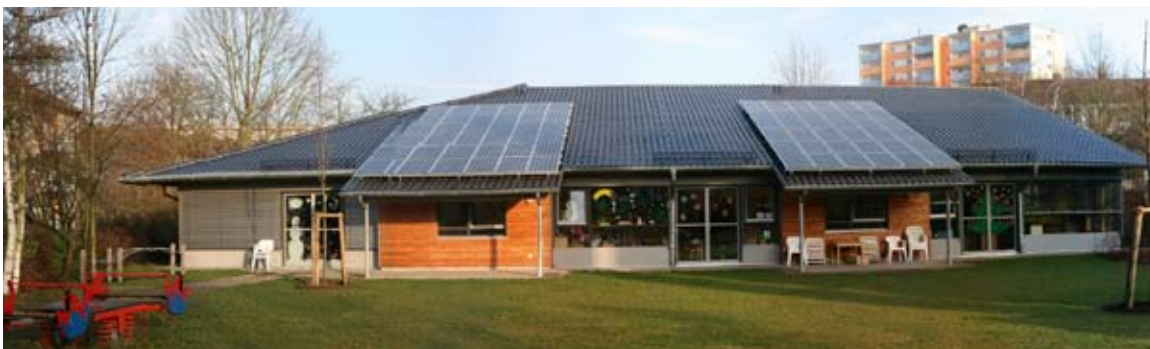
Solaranlage auf dem Heilig-Geist-Kindergarten. Bild: Frieß
